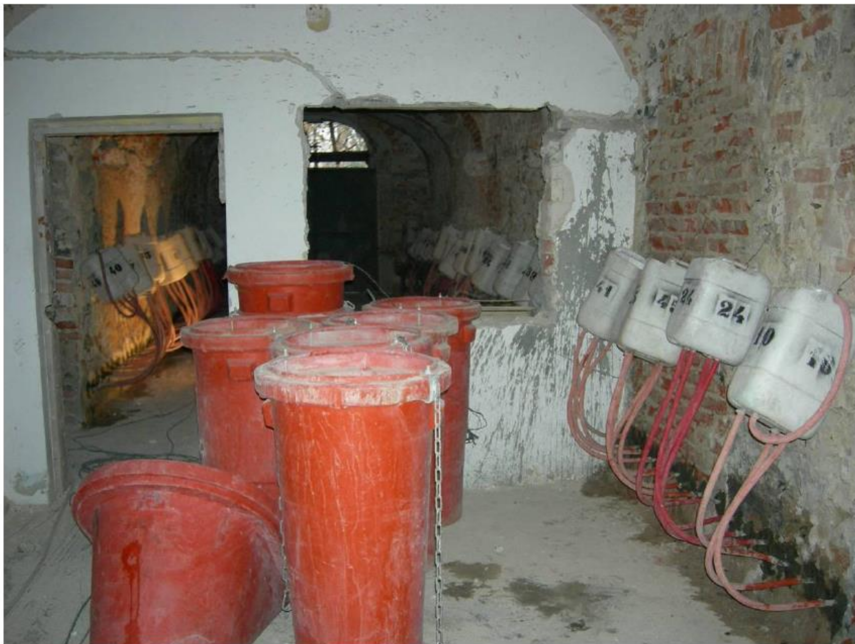
Slika 10: Izvedba hidrofobne bariere z raztopino silikonov
