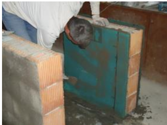
Ojačanje zida od blok opeke „FRCM“ sistemom
